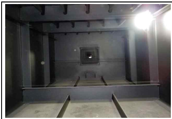
위치: Steel Box Girder(내부)
