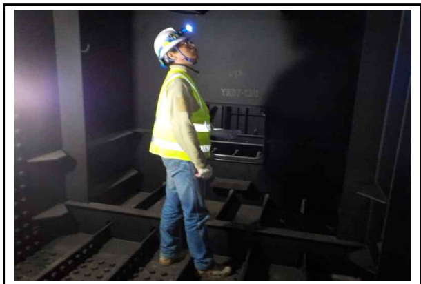
위치: Steel Box Girder(내부)
