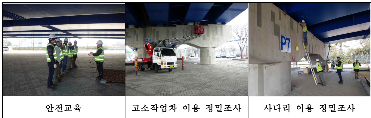
<사진 2.1.2> 외관조사 현황
